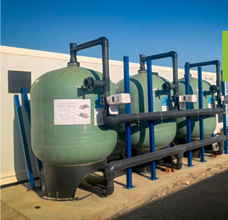
Avance del 70% en instalación de Planta de Ósmosis Inversa con capacidad de producción de 150 m 3 /hora
