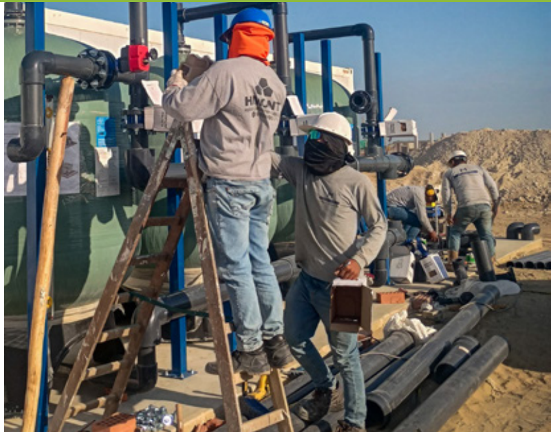
Avance del 70% en instalación de Planta de Ósmosis Inversa con capacidad de producción de 150 m 3 /hora
