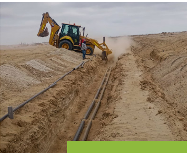
Avances al 80% en instalación de tuberías, mangueras y válvulas hidráulicas
