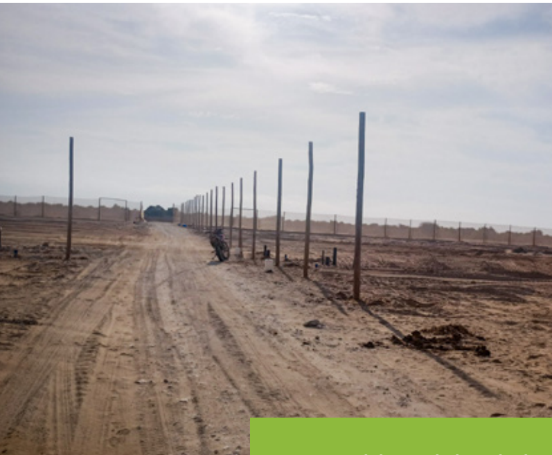
Avance del 40% de instalación de cortinas rompeviento
